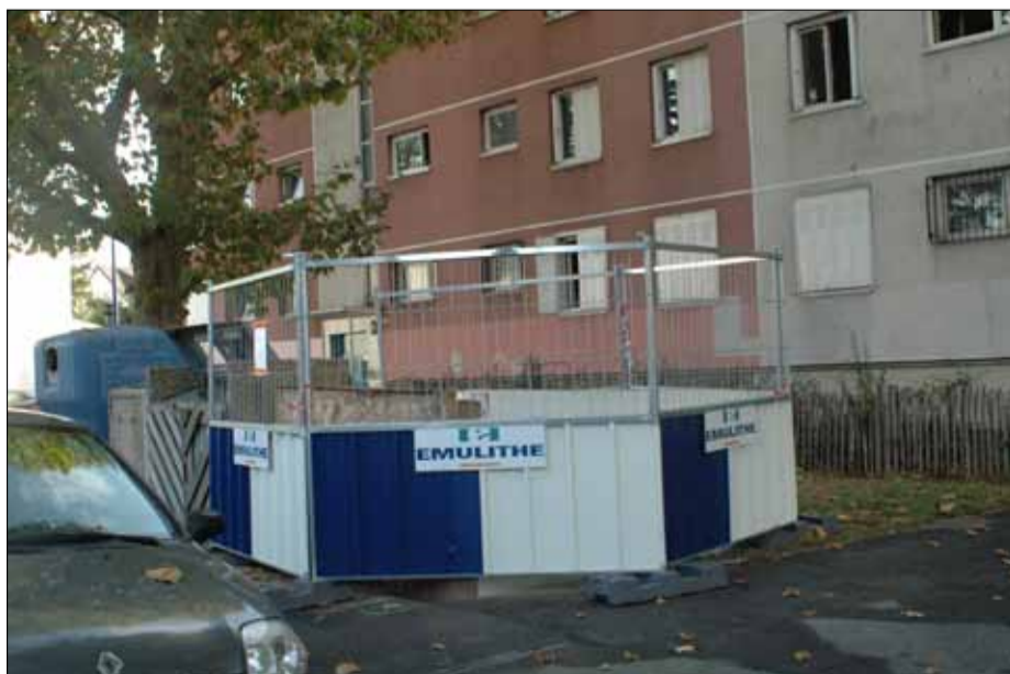
* Ici, avenue Pradier dans le quartier Village parisien, un conteneur enterré est également en cours d'installation. L'ancien conteneur bleu que l'on voit au second plan sera installé à un autre endroit, permettant d'augmenter le maillage fin des quartiers en conteneurs et limitant ainsi les déplacements des Drancéens pour le recyclage du verre.
