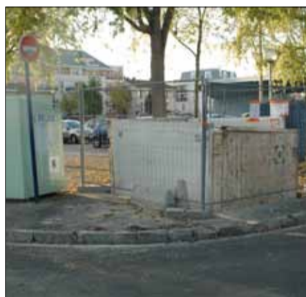
* Bientôt à cet emplacement, à l'angle du parking de l'Espace culturel et de la rue de Ladoucette, un nouveau conteneur à verre enterré.
