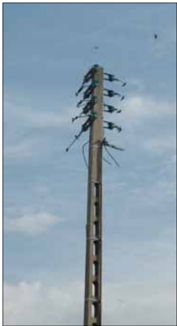
* Ces poteaux électriques en béton vont progressivement disparaître de nos rues, au fur et à mesure de l'enfouissement des réseaux électriques.
